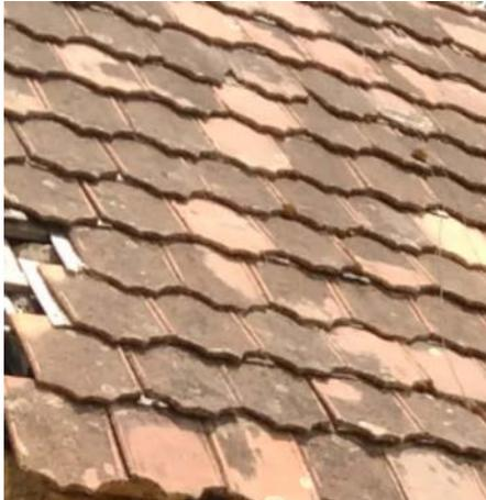
Figura 1. Detalles de la colocación de teja y traslapes de unión (crédito: C. Porcayo)
