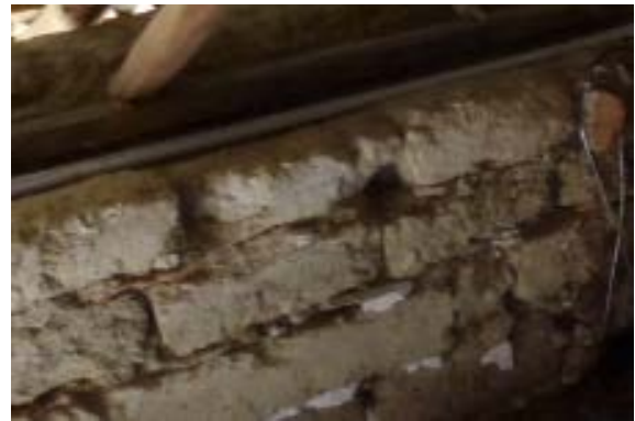
Figura 3. Restauración de muro de adobe
