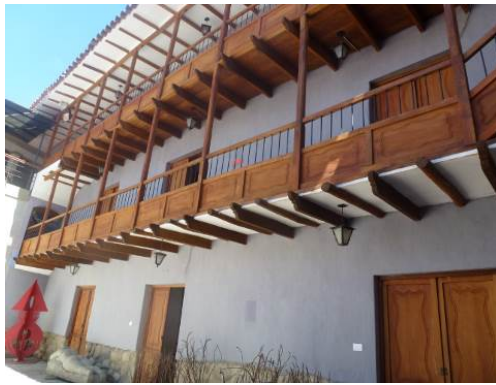
Figura 8. Vista interior del tambo
