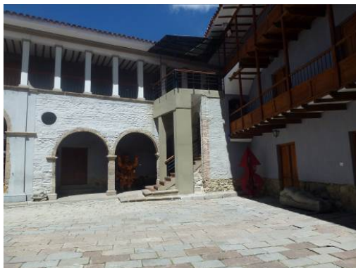
Figura 6. Vista del patio principal
