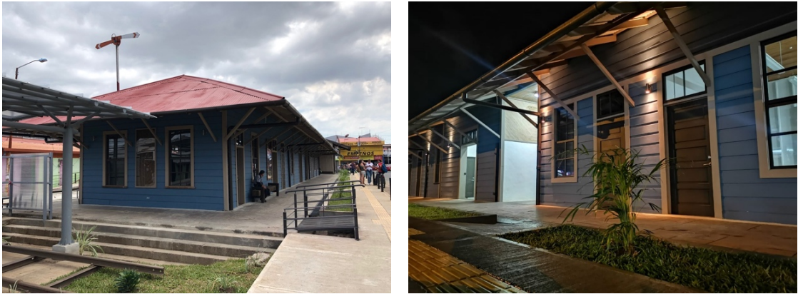
Figura 16. Fachadas terminadas. Fachada de bahareque cubierto con tabla en el exterior y gradería descubierta y fachada norte con pasillo central e iluminación (Crédito: M.B. Esquivel 2019)
