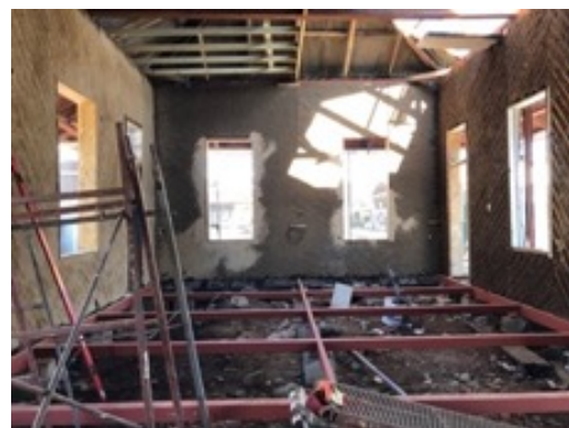
Figura 7. Pared de bahareque restaurada. recomposición de ventanas y revocos de tierra y cal. (Crédito: M. B. Esquivel, 2019)
