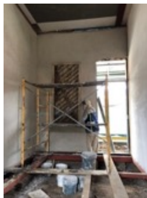
Figura 20. Testigos del sistema constructivo del bahareque dejados en diferentes paredes para mostrar las particularidades de la técnica original (Crédito: M.B. Esquivel 2019)
