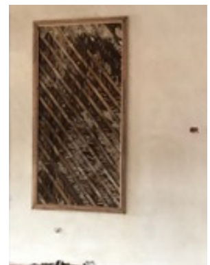
Figura 20. Testigos del sistema constructivo del bahareque dejados en diferentes paredes para mostrar las particularidades de la técnica original (Crédito: M.B. Esquivel 2019)
