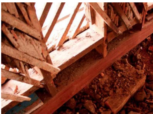
Figura 12. Revisión de fijación columnas a viga solera y corona (Crédito: Tuk y Fallas, 2019).
