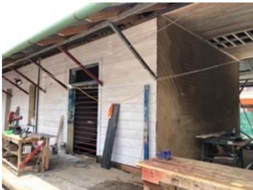
Figura 18. Sección de bahareque con forro exterior de tabla. Pared del pasillo central quedará con barro visto como testigo del sistema constructivo
