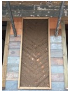
Figura 20. Testigos del sistema constructivo del bahareque dejados en diferentes paredes para mostrar las particularidades de la técnica original (Crédito: M.B. Esquivel 2019)
