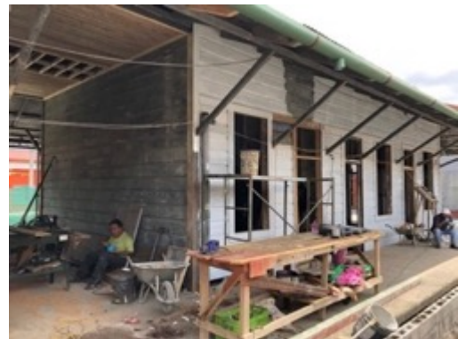
Figura 19. Sección de madera dividida por pasillo central. Tabla Antigua vista como testigo del Sistema constructivo de madera
