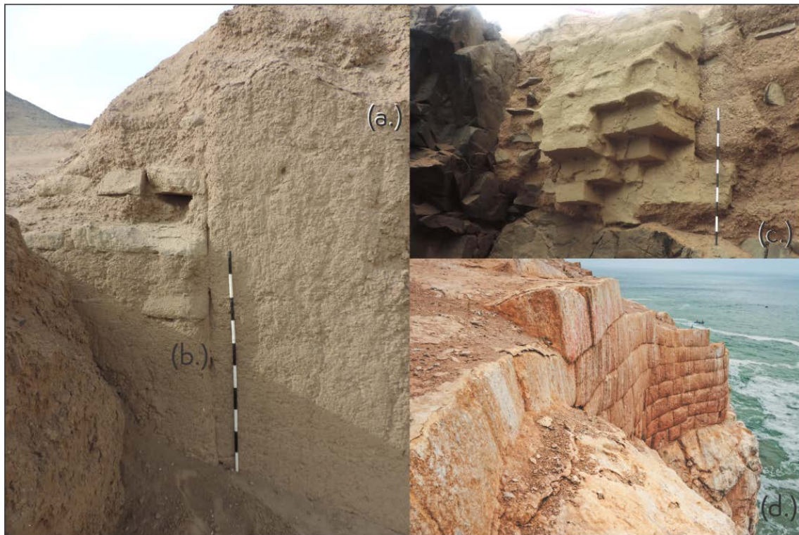
Figura 4. Técnicas constructivas en El Huarco-Cerro Azul: (a.) muro de tapial, (b.) muro de tapial y adobe, (c.) muros de adobe, (d.) mampostería de sillar. (fuente: Proyecto Qhapaq Ñan-Sede Nacional)
