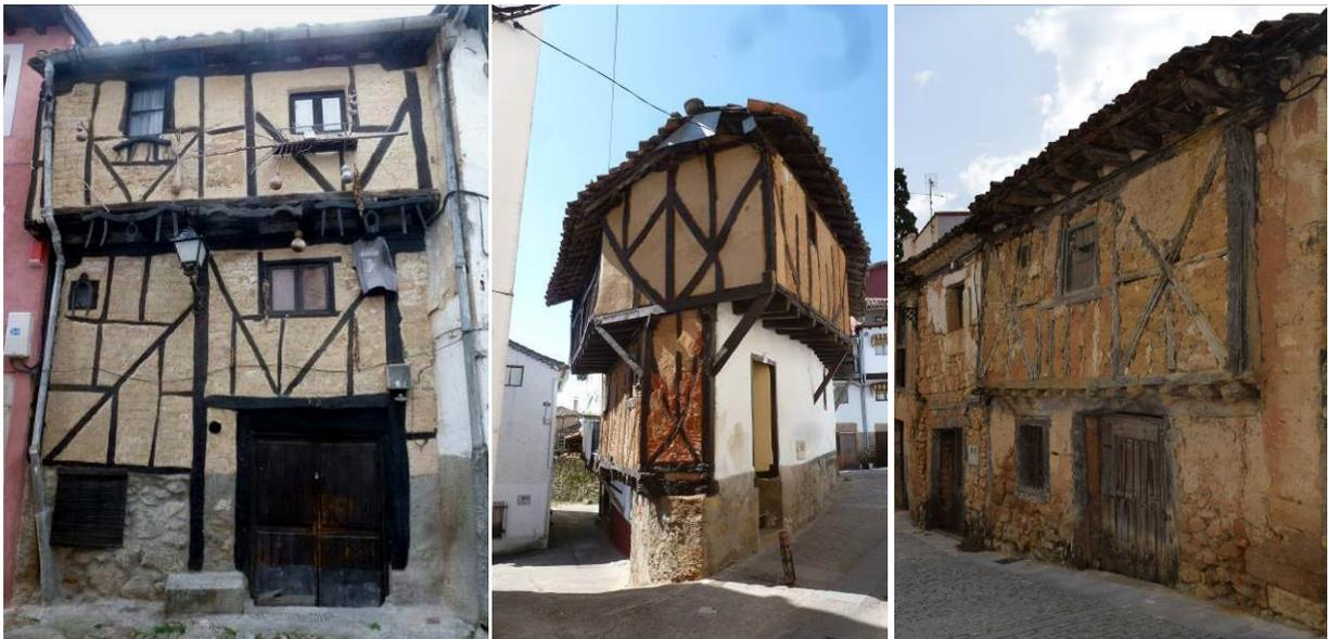
Figura 6. Diferentes ejemplos de muros entramados con presencia de elementos intermedios compuestos. De izquierda a derecha: Cuacos de Yuste (Cáceres), Villanueva de la Vera (Cáceres) y Santo Domingo de Silos (Burgos). (Crédito: F. V. López-Manzanares, C. Mileto)
