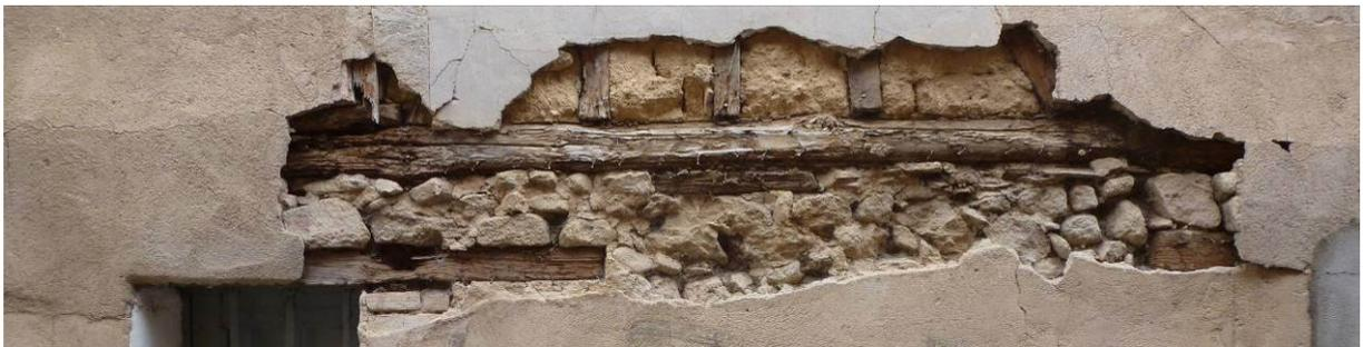
Figura 1. Detalle del muro entramado oculto bajo el revestimiento, en Garganta de la Olla (Cáceres).
