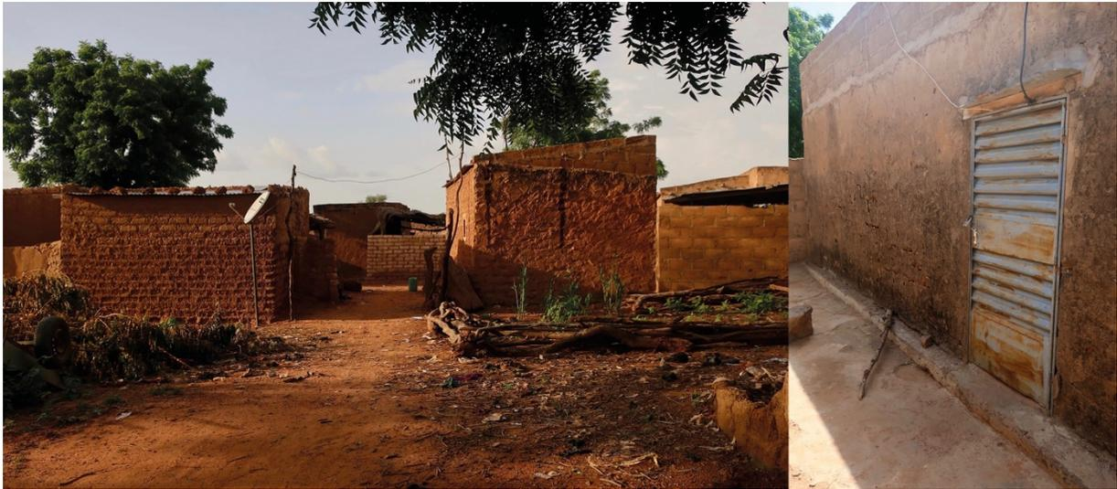
Figura 6. Algunas de las transformaciones, como la ampliación con bloque de cemento, el uso de carpintería metálica o la construcción de cubiertas con chapa metálica ondulada.
