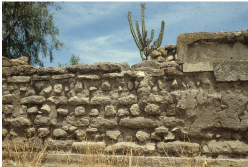
Figura 3. Muro elaborado con varias capas de tierra y piedra (Crédito: B. Fahmel, 1987)
