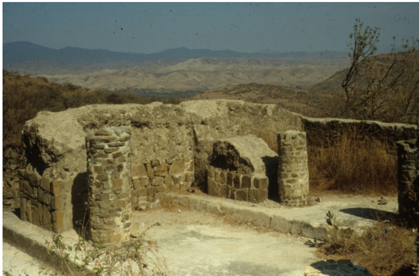
Figura 2. Aspecto original de los adobes en el edificio X de Monte Albán (Crédito: B. Fahmel, 1987)
