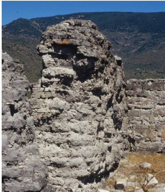
Figura 5. Muros de adobe construidos en la Fortaleza de Mitla (Crédito: B. Fahmel, 1987)
