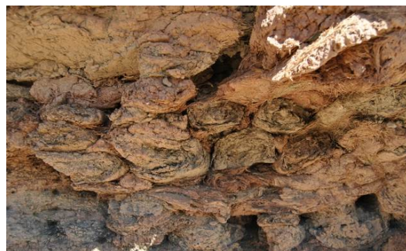
Figura 6.- a) Adobe con rollo (Ejra) Caquiaviri; b) Chullpawawas en el muro exterior de chullpa con adobes en el interior de la cámara funeraria (Nazacara Caquiaviri) (crédito: I Delaveris)
