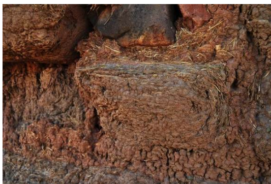
Figura 6.- a) Adobe con rollo (Ejra) Caquiaviri; b) Chullpawawas en el muro exterior de chullpa con adobes en el interior de la cámara funeraria (Nazacara Caquiaviri) (crédito: I Delaveris)
