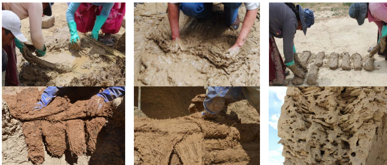
Figura 6.- Conformación de la chullpawawa con pajas enteras, las cuales se amasan y toman la forma de bloques alargados, estos deben apilarse en fresco para conformar la chullpa . Al parecer las puntas que dan al exterior sobresalían para hacer unos dobles y conformar la siguiente fila del apilado (crédito: I. Delaveris)
