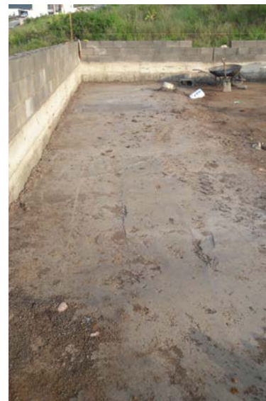
Figura 4. Plataforma estabilizada en fraccionamiento residencial, Morelia, Michoacán: a) Mezclado con maquinaria; b) Compactación y curado (crédito E. Navarro, 2016)
