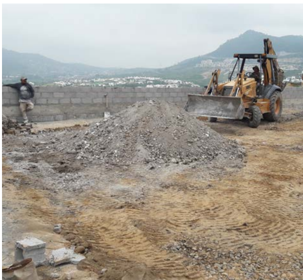
Figura 4. Plataforma estabilizada en fraccionamiento residencial, Morelia, Michoacán: a) Mezclado con maquinaria; b) Compactación y curado (crédito E. Navarro, 2016)
