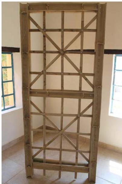
Figura 3. El panel se ensambla a partir de la unión de polines de bambú y tejido central de latas de bambú que rigidizan la pieza y soportan el embarrado (crédito: J. Soria)
