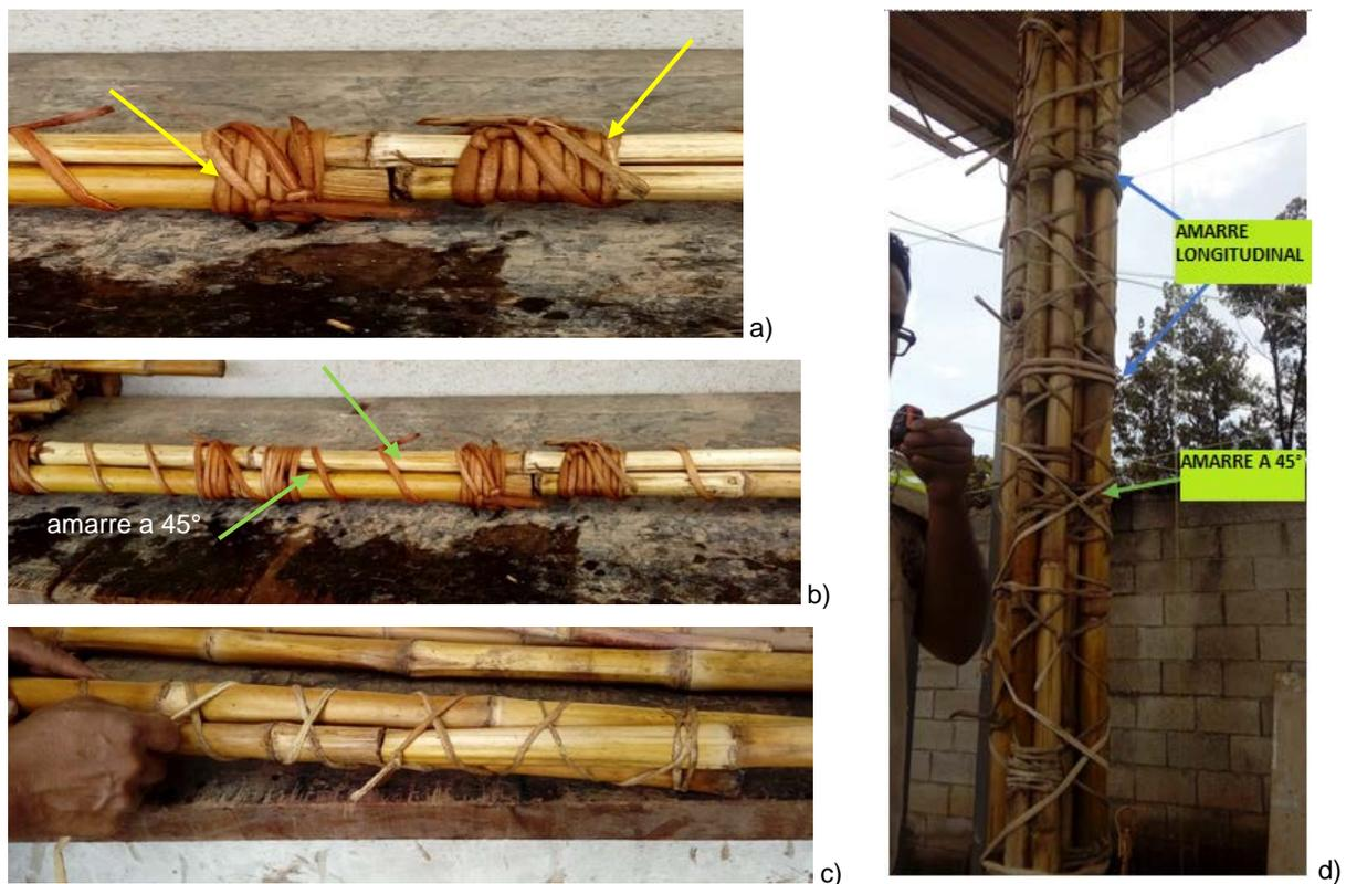
Figura 3. a) Detalle del primer amarre del paquete de cañas; b y c) Detalle del amarre en forma de cruceta del paquete de cañas; d) Detalle de armado de columna propuesta
