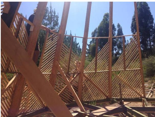
Figura 7. Disposición de los elementos principales con cadenas horizontales
