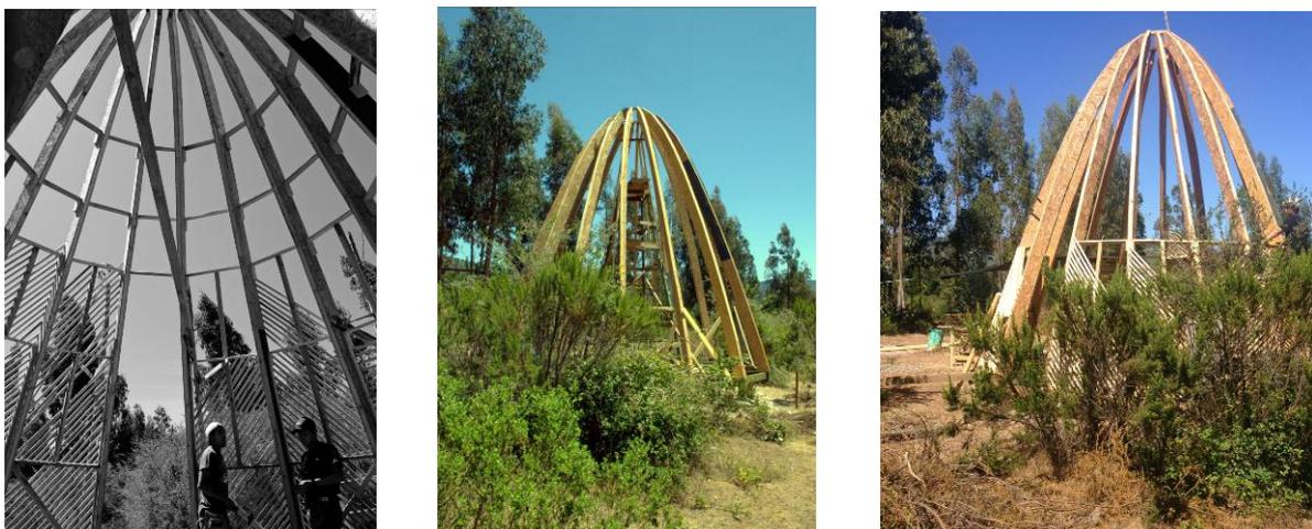
Figura 3. Montaje de quincha entre elementos parabólicos prefabricados (crédito: F. M. López)
