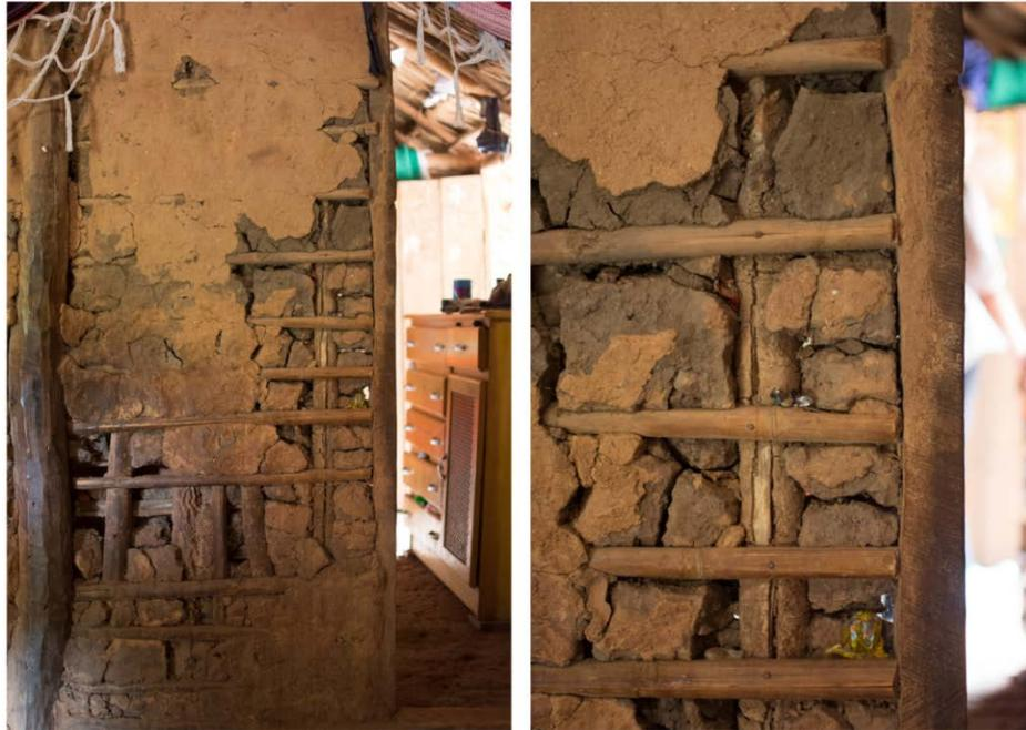
Figura 4. Detalhe da parede de taipa de mão
