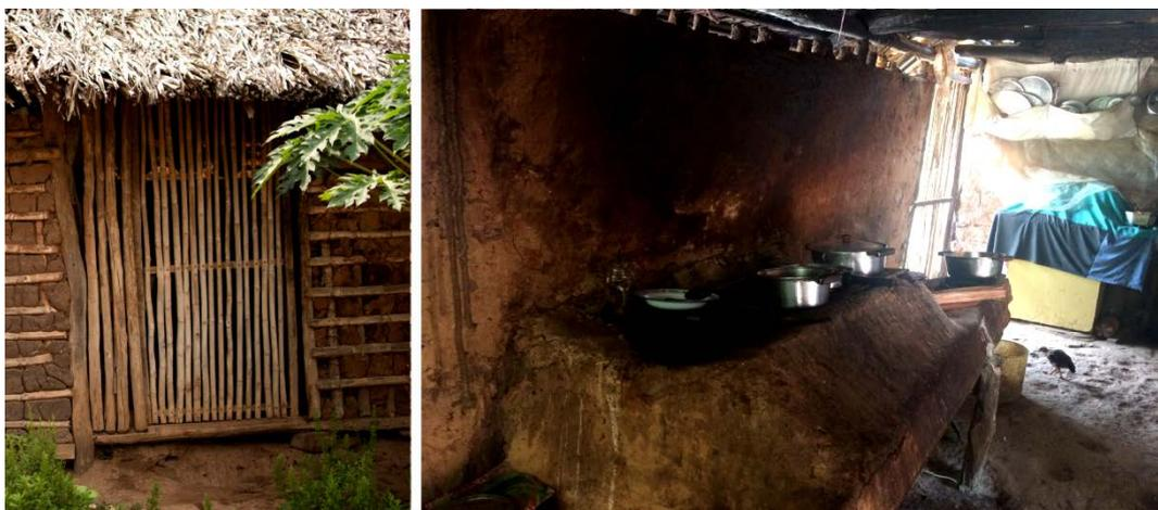
Figura 6. Cozinha externa e internamente com madeiras verticais não revestidas para ventilação
