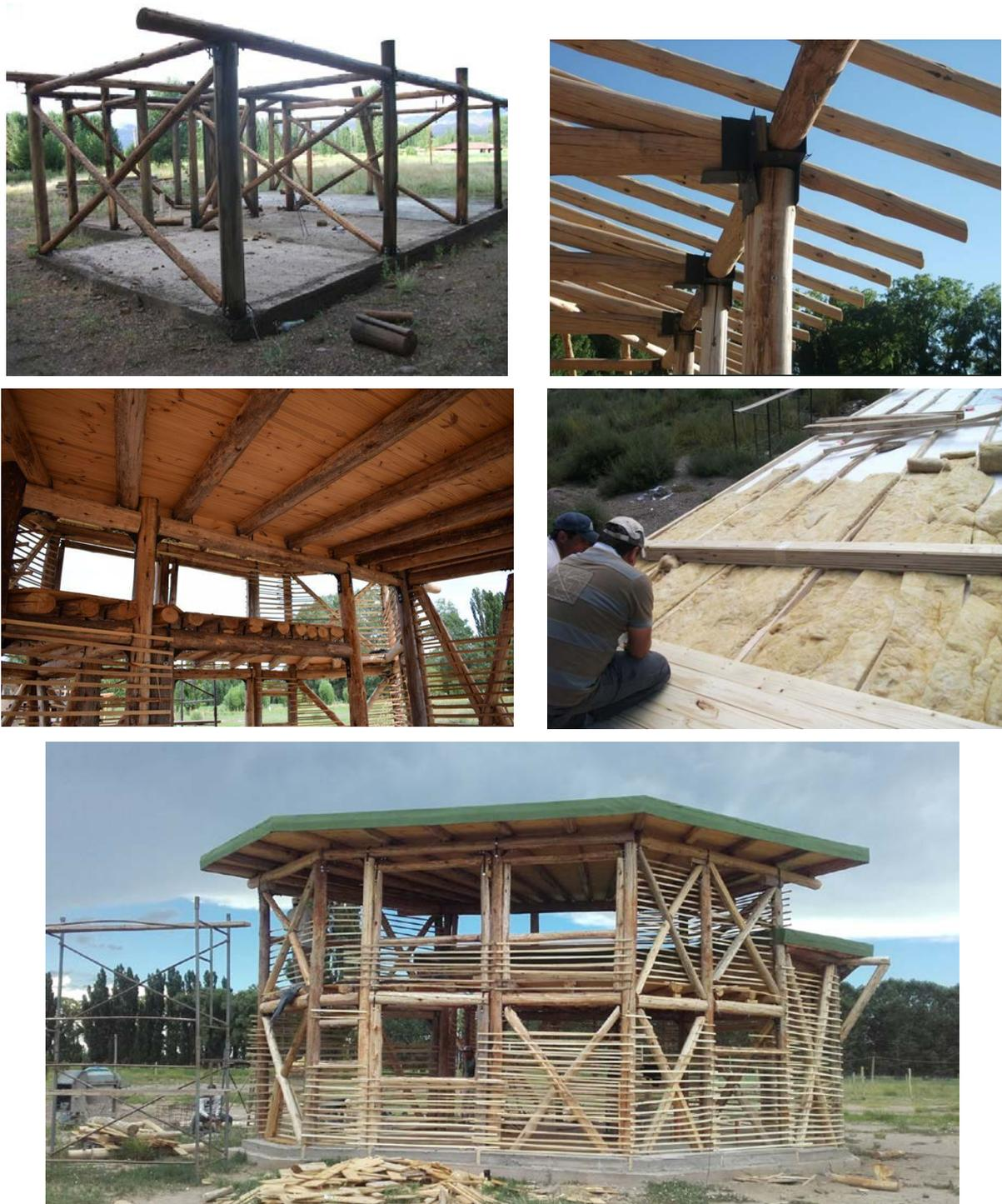
Figura 2. Detalles constructivos de la técnica quincha. Estructuras de madera, platinas y cubiertas de techos
