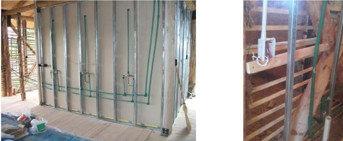
Figura 3. Detalles constructivos. Construcción en seco elegida para las instalaciones
