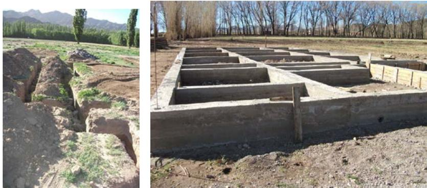
Figura 1. Detalles constructivos de la preparación del terreno y cimentaciones
