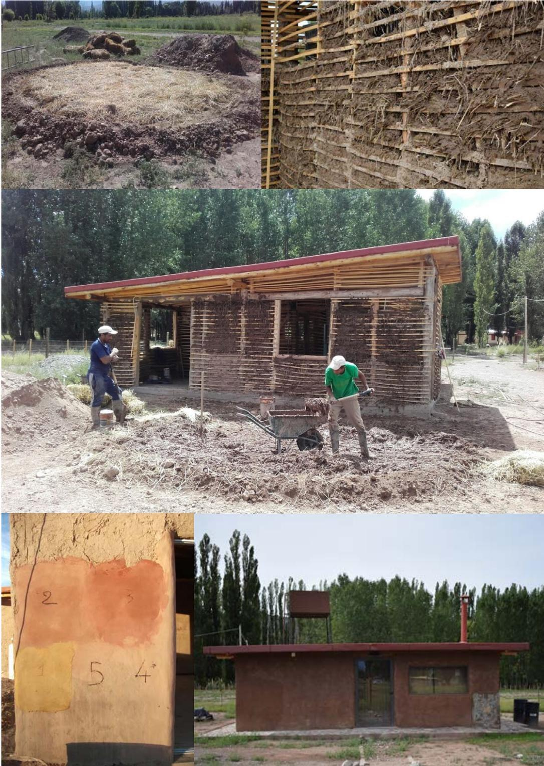
Figura 4. Detalles constructivos de la técnica quincha. Relleno y revestimiento.
