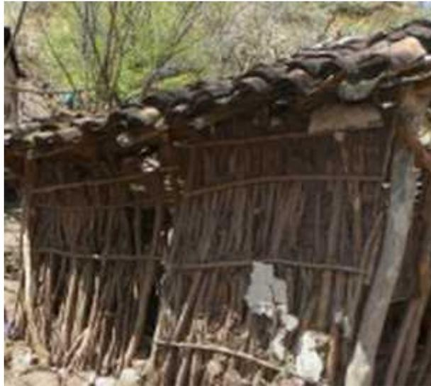
Figura 3. Casa embarrada degradada
