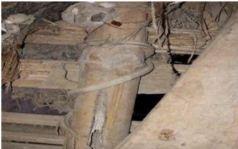
Figura 2. Detalle de amarre en pared embarrada
