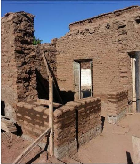
Figura 7. Reconstrucción de muros de adobes liberados
