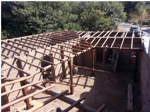
Figura 9. Colocación de varas de eucaliptus para la cubierta de torta de barro
