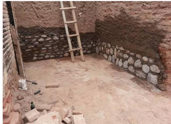
Figura 6. Recalce de muros erosionados con suelo cemento y piedra
