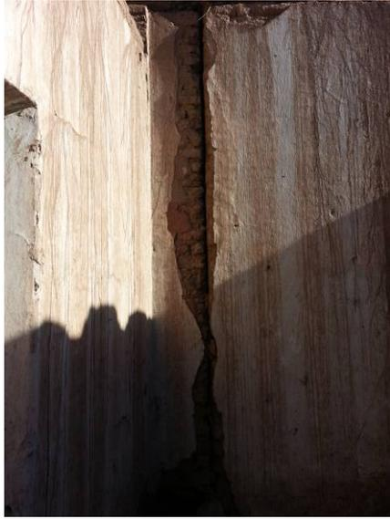
Figura 3. Falta de arriostramiento vertical entre muros
