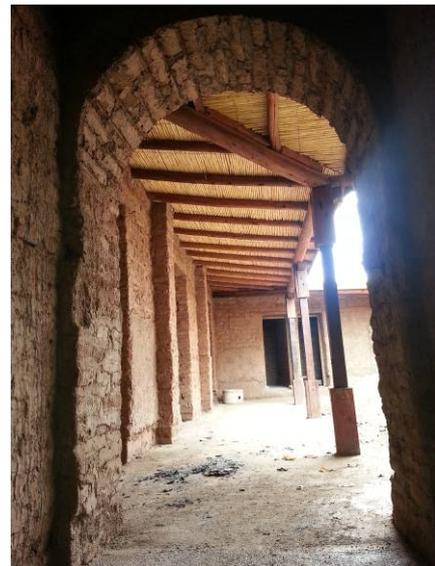
Figura 10. Vista de la galería con sus columnas de madera reciclada
