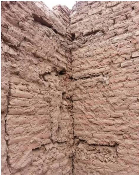
Figura 5. Colocación de llaves de madera dura en los encuentros de muros
