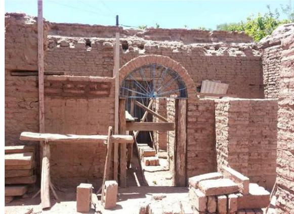
Figura 8. Reconstrucción de un arco de medio punto de adobe
