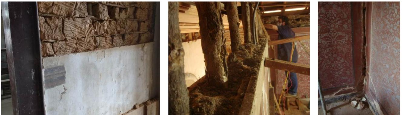
Figura 7: Sistema construtivo: pau a pique. Observa-se o precário estado de conservação tanto do suporte quanto da pintura parietal. (crédito: I. Ramos, 2015)
