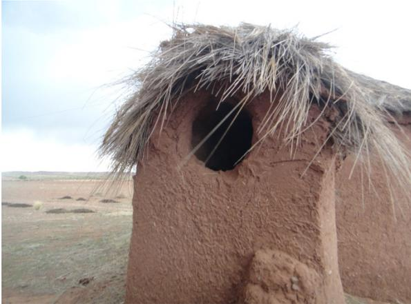
Figura 5. Orificio superior de la Pirwa
