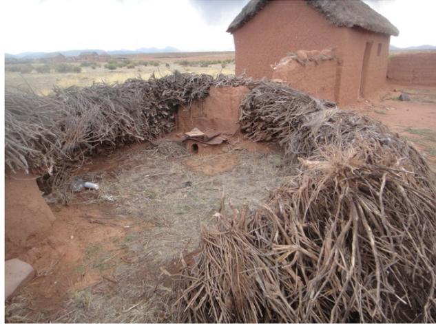
Figura 3. Disposición de la qincha y el qiri
