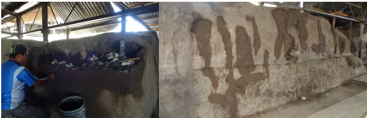
Figura 7. Restitución de volúmenes, cierre de grietas en perfiles de excavación (crédito: J. Alvarez, 2016)
