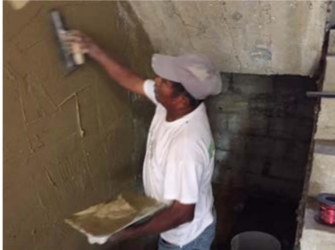
Figura 11. Aplicación la mezcla sobre muro convencional de block de concreto
