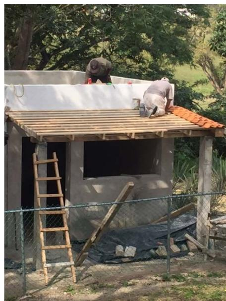
Figura 2. Prototipo de tierra vertida: a) construcción de los muros; b) colocación de tejas
