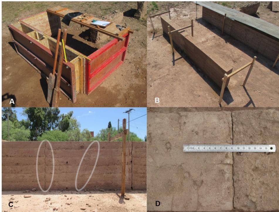
Figura 4. A) Tapial y pisones. B) Vista general de la Serie1. C) Murete T1, juntas con contorneo en blanco. D) Registro de fisuras
