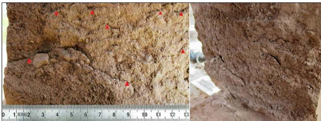
Figura 6. Fisuras y microfisuras observadas en junta vertical, sobre cara de contacto de la tapia receptora
