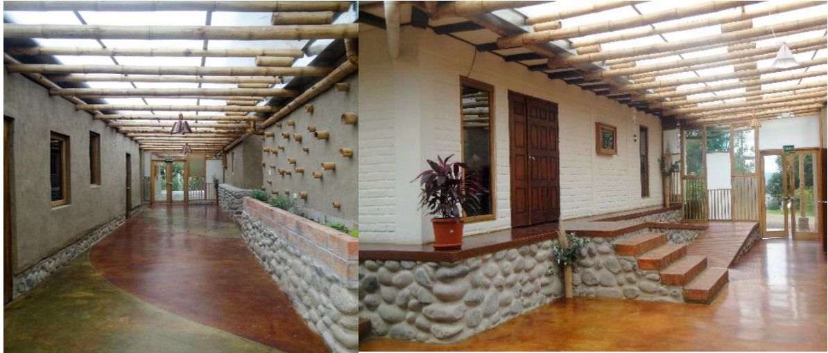
Figura 1. Pisos de tierra de la vivienda Nina Huasi (Huiracocha, 2014)
