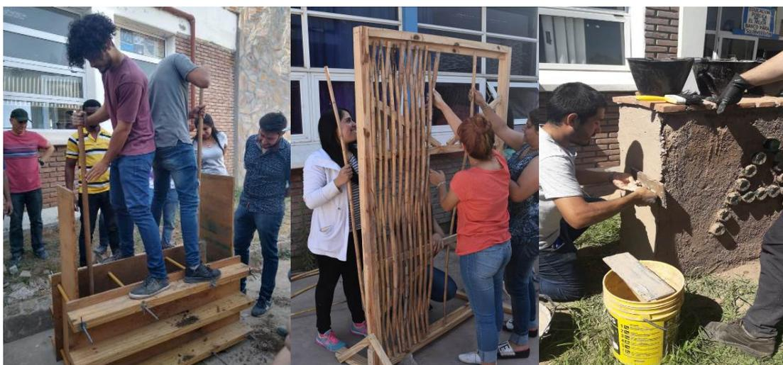
Figura 3. Taller de tapial, taller de quincha, taller de revoques y revestimientos, materia construcciones con tierra, carrera de arquitectura, UNLaR (Crédito: E.E. Brizuela)
