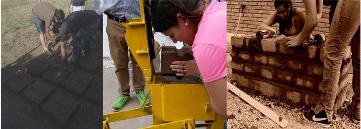
Figura 2. Taller de adobe, taller de bloque de tierra comprimida, taller de albañilerías, materia construcciones con tierra, carrera de arquitectura, UNLaR (Créditos: L Caleri, C. Revuelta)
