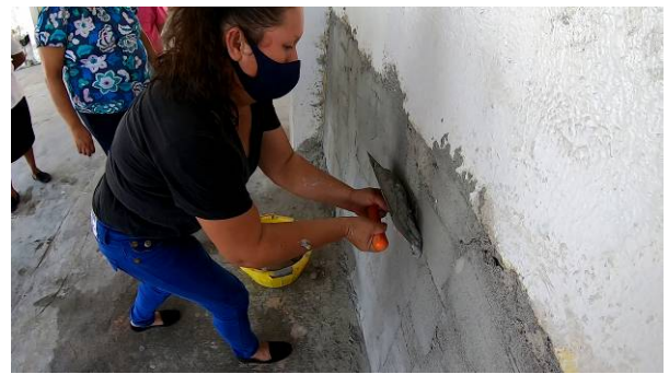
Figura 6. Aplicación de revoque fino de cal-arena
