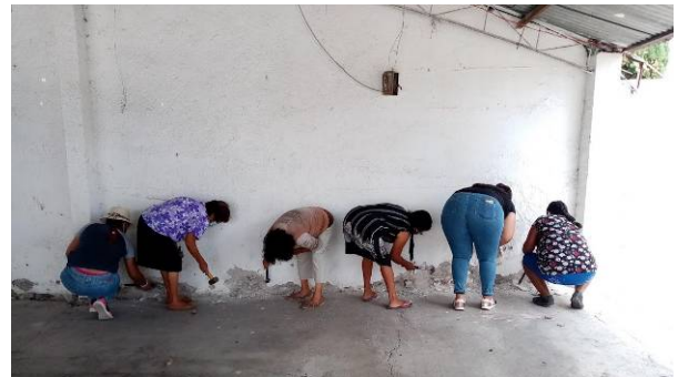
Figura 4. Mujeres quitando el revoque dañado en Huatecalco
