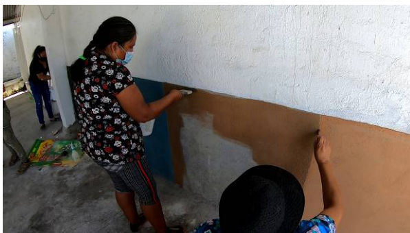
Figura 7. Aplicación de pintura a la cal
