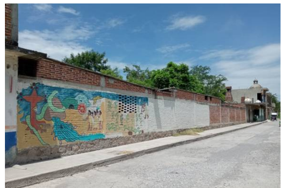
Figura 12. Muro en Xoxocotla.
