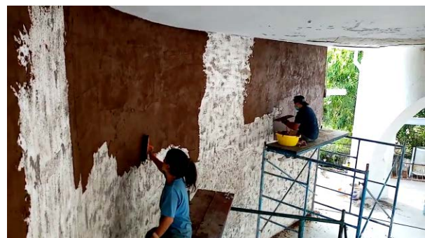
Figura 14. Revoque de tierra sobre puente de agarre. Crédito: Alexis Yael
