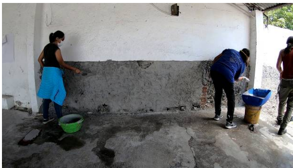
Figura 5. Aplicación de revoque base de cal-arena
