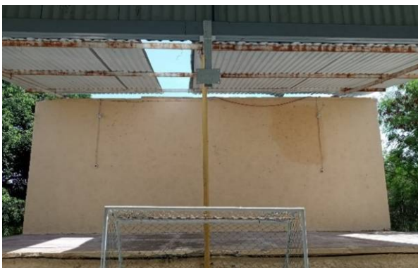
Figura 11. Muro en la cancha, frente al ayuntamiento de Tequesquitengo
