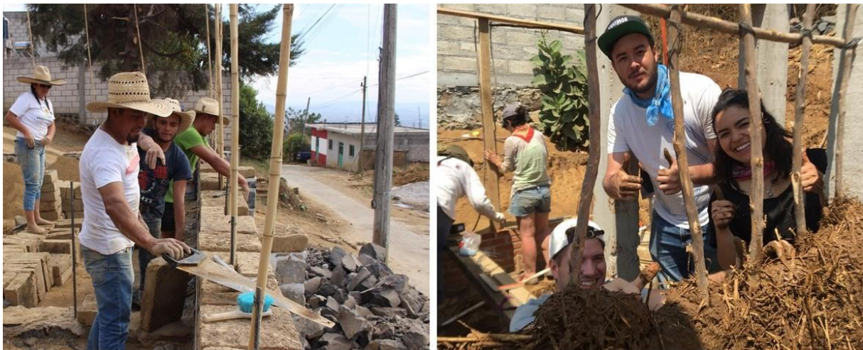
Figura 5. Estudiantes de la UMA colaboran en la construcción de la obra escuela “Centro Comunitario Creativo Totolapan”
