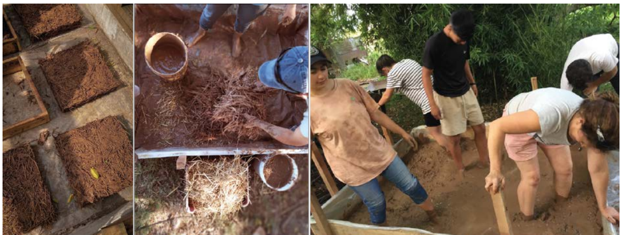
Figura 4. Realización BTA y pisadero. Noviembre de 2021 (Crédito: Pasantía Bio Casa Va)
