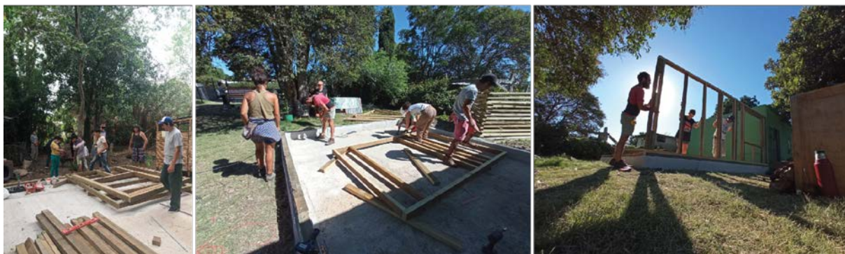
Figura 5. Realización de jornada de construcción de bastidores: taller facilitado por Yamila Castro y Ronny Perera. (Créditos: equipo operativo del CAVHE, FADU, Udelar)
