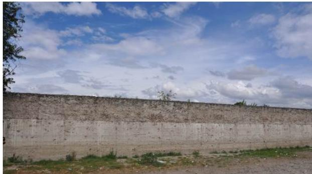
Figura 1. Tapias de Tepeyahualco (acervo del Laboratorio de Procedimientos y Sistemas Constructivos Tradicionales, LPSCT)
