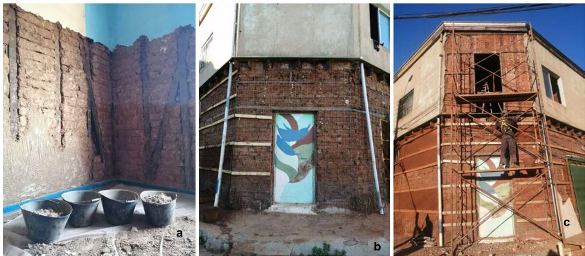
Figura 6: Obras realizadas: a) retiro de estucos interiores; b) reforzamiento de muro de adobe con malla electrosoldada; c) retiro de estucos en segundo piso y colocación de estucos en primer piso.
