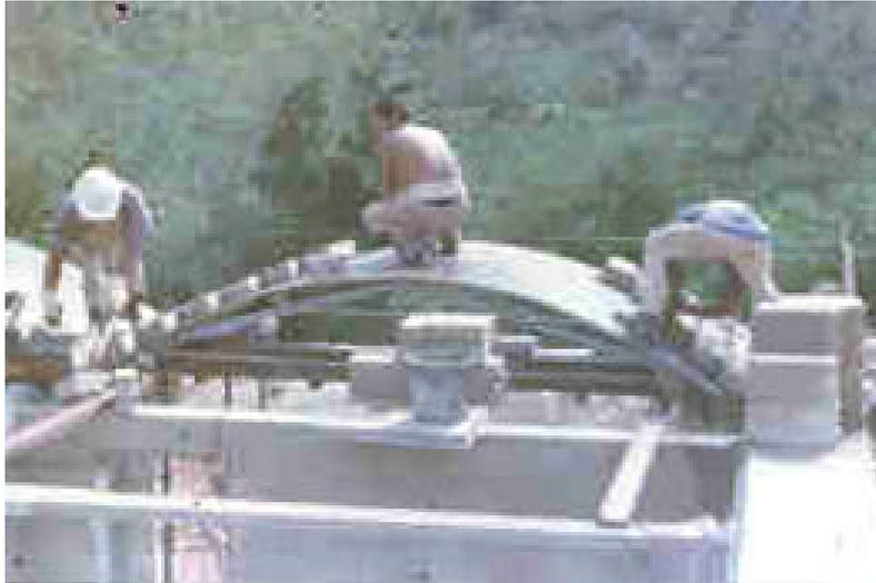
Figura 3. Construcción de techo de bóveda de 3.60 m de luz con bloques de Suelo Cemento
