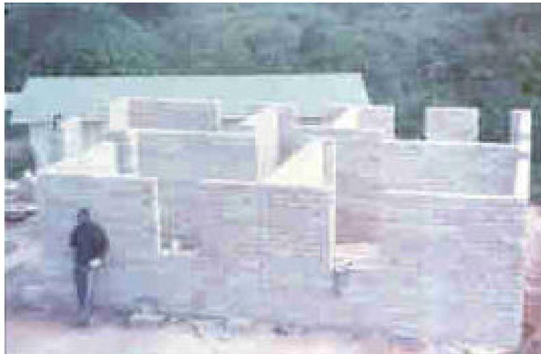
Figura 2. Paredes de una vivienda de 69 m<sup>2</sup> de superficie con bloques machihembrados de suelo cemento
