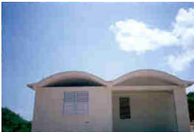
Figura 4. Vivienda terminada de 69 m<sup>2</sup> con paredes de Bloques Machihembrados de Suelo Cemento Prensado y techo de Bóveda de Bloques de Suelo Cemento.
