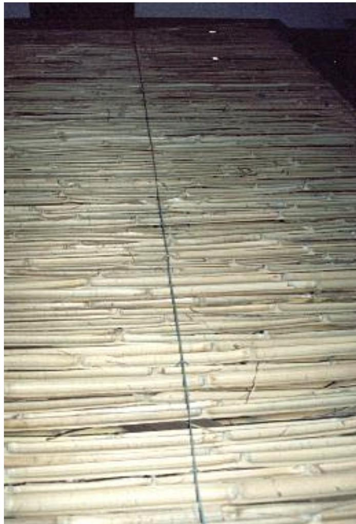
Foto 4: Paneles de caña y tierra – cemento
