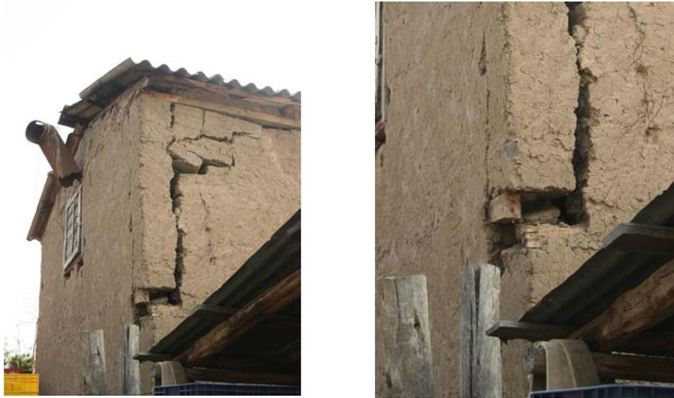
Figura 7. Daño de horno en Panguesillo, asociado al vínculo deficiente entre los elementos de refuerzo horizontales de madera
