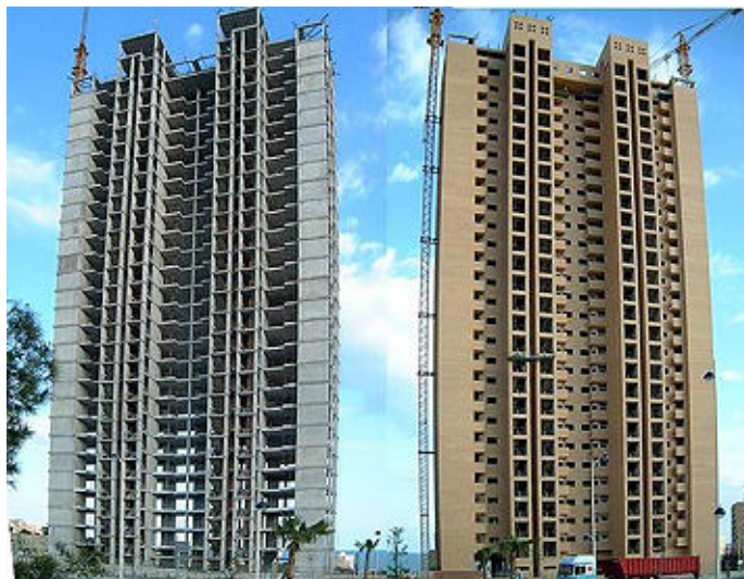
Fig. 4. Cierre de las fachadas con ladrillo cara vista en un
