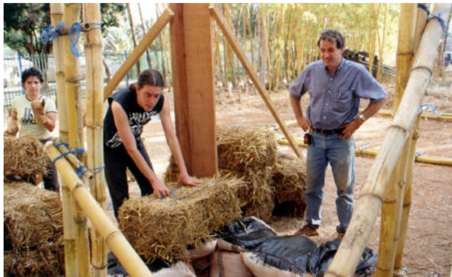
**Foto 4 :** Construcción de un módulo aplicando la técnica constructiva de la paja (*Márcio Buson 2000*).
