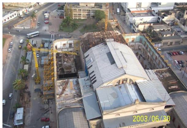
Figura 13: Apuntalamiento de Paredes
