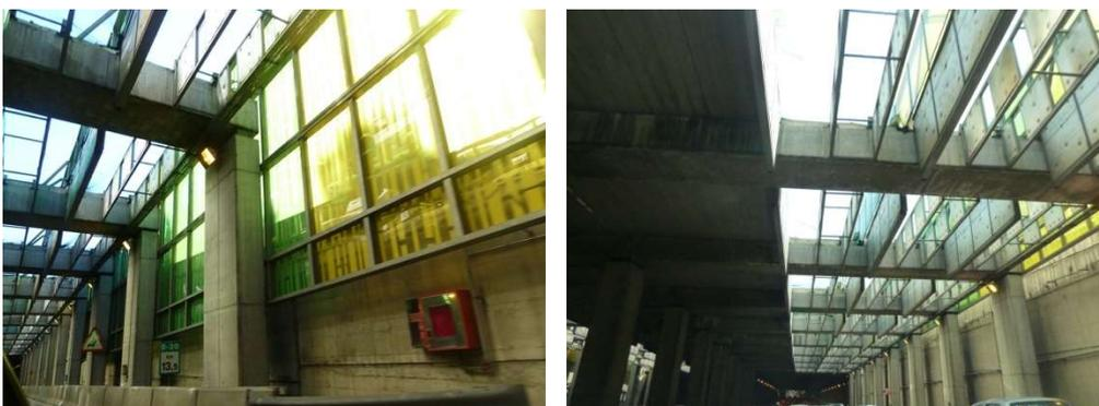
Figuras 45 y 46. Filtros formados por absorbentes a modo de bafle colgante. Fotografía: Daumal, F.
