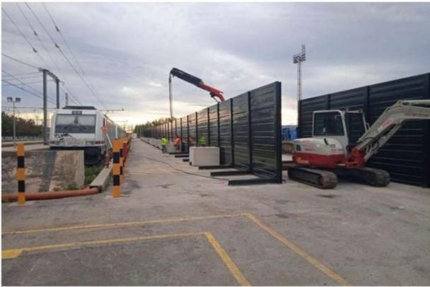
Figura 2. Pantallas provisionales y desmontables. Fuente: prospecto en Internet
