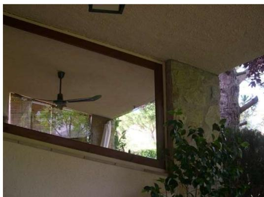
Figura 13. Cerramiento con mampara acristalada de los porches entre dos casas pareadas. Fotografía: Daumal, F.
