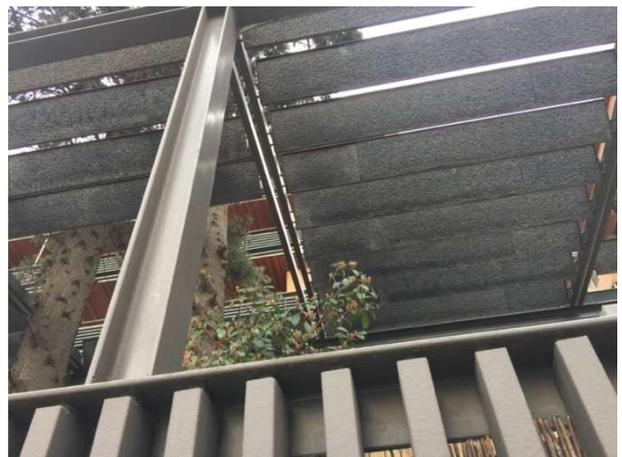
Figuras 50 y 51. Pérgola absorbente de un edificio en Barcelona. Fotografía: Daumal, F.
