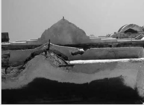
**FIGURA 5.** CORNISAS DE ABERTURAS Y SALIENTES, SE OBSERVA SUCIEDAD, FISURAS, DESPRENDIMIENTOS Y HIERROS CON CORROSIÓN. 2019, ELABORACIÓN PROPIA.
