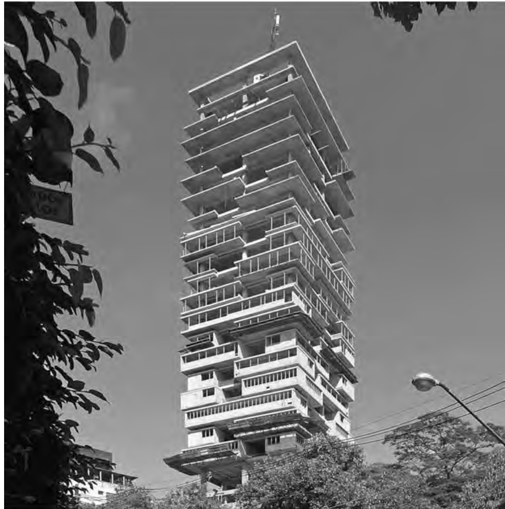
FIGURA 8: ISAY WEINFELD E DOMINGOS PASCALI. EDIFÍCIO 360°, SÃO PAULO, EM CONSTRUÇÃO. FOTO LUIS ESPALLARGAS
