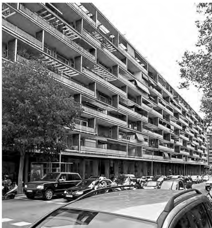
FIGURA 6. FRANCESC MITJANS. EDIFÍCIO SEIDA, 1958, BARCELONA, ESPANHA. FOTO HELIO PIÑÓN
