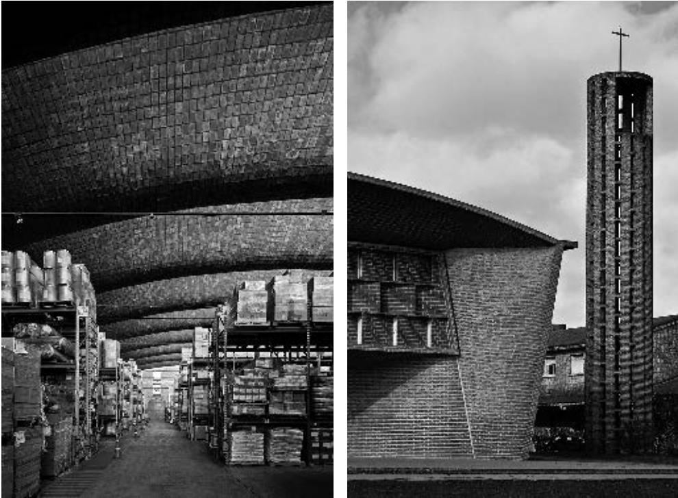
FIGURA 3. DEPOSITO JULIO FERRERA Y OBES + IGLESIA DEL CRISTO OBRERO, ELADIO DIESTE
