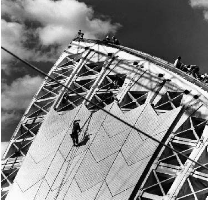
FIGURA 2. CONSTRUCCIÓN DE LA OPERA DE SIDNEY. JØRN UTZON - OVE ARUP.
