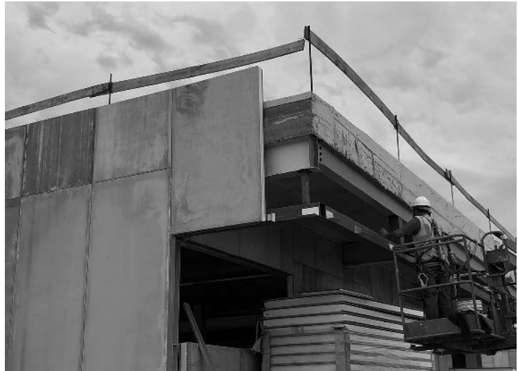
FIGURA 9. COLOCACIÓN DE PANELES DE FACHADA.
