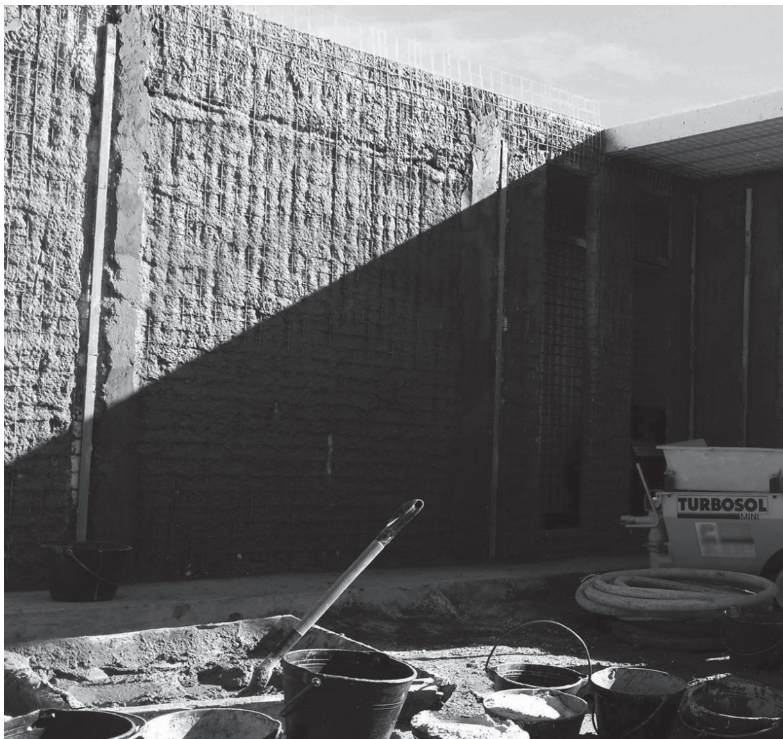
SISTEMA CONCREXPUMA. FOTOS: BROMYROS S.A
