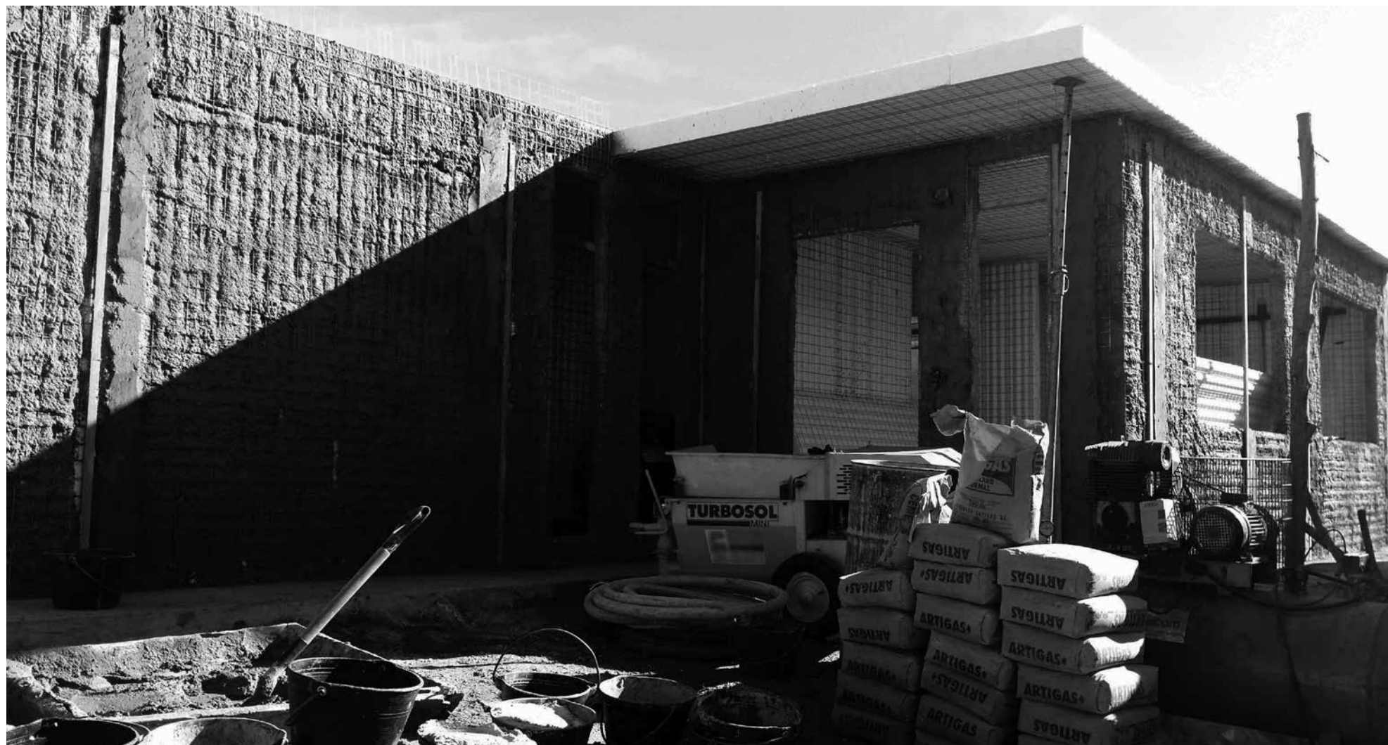
SISTEMA CONCREXPUMA. FOTOS: BROMYROS S.A
