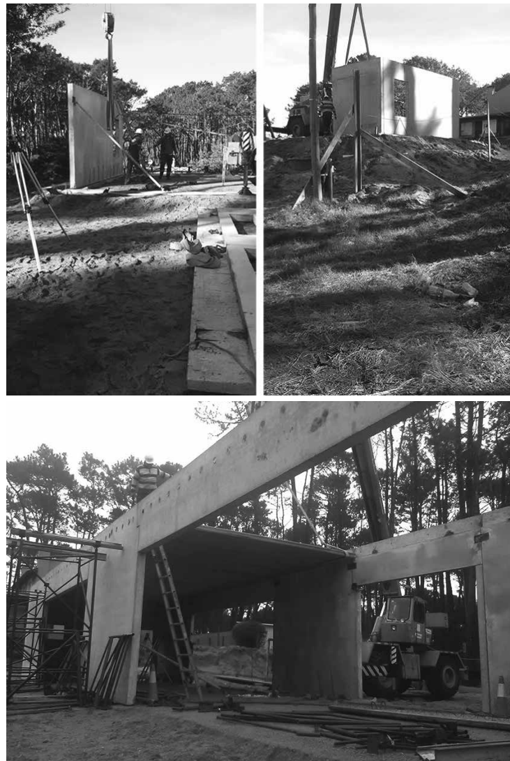
FIGURA 2. MONTAJE DE PANELES Y AVANCE DE CONSTRUCCIÓN EN VIVIENDA UNIFAMILIAR EN OCEAN PARK, URUGUAY. FOTOGRAFÍA: ANIELA SOLIÑO.
