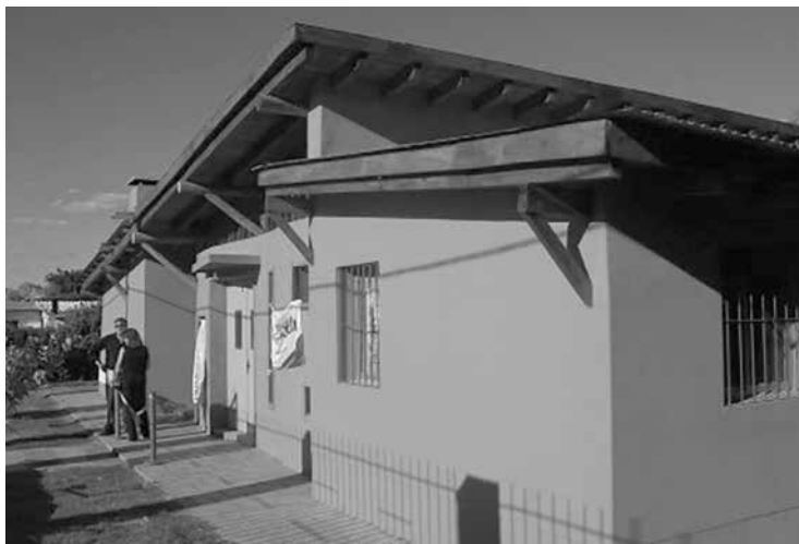
FIGURA 5. SALÓN COMUNAL EN CAIF DEL BARRIO PURIFICACIÓN, PAYSANDÚ. FUENTE: ELABORACIÓN PROPIA.
