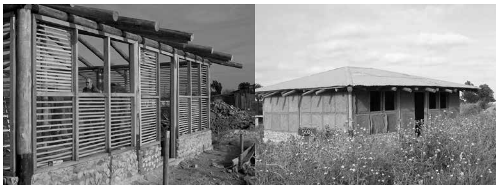
FIGURA 3. CASA VAIMACA. PANELES DE FAJINA. FUENTE: PÁGINA WEB DE TIERRA AL SUR (WWW.TIERRAALSUR.COM).
