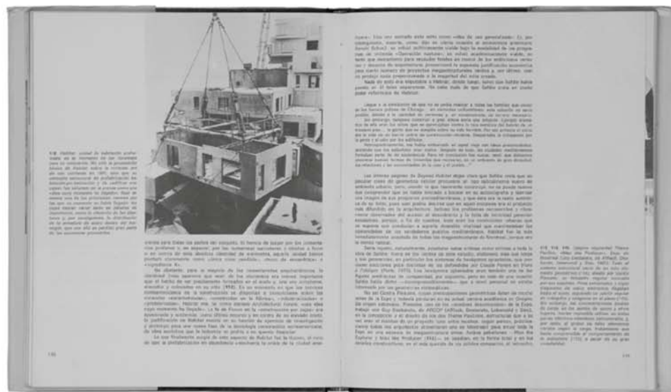
FIGURA 5. UNIDADES PREFABRICADAS DE VIVIENDA DEL CONJUNTO HABITAT PROYECTADO POR MOSHESADIE EN MONTREAL. FUENTE: MEGAESTRUCTURAS. FUTURO URBANO DEL PASADO RECIENTE DE BANHAM, R., 1978, PP. 110-111, BARCELONA: GUSTAVO GILI. FOTOGRAFÍA: MARÍA NOEL VIANA, SMA.
