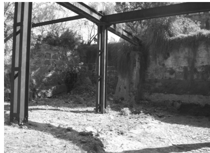
FIGURA 4. CONTRAESCARPA Y FOSO DE LA BATERÍA DE SAN PASCUAL. FUENTE: ONEGA, E. (2008). INFORME PROYECTO «MURALLA DE MONTEVIDEO» . MONTEVIDEO: FACULTAD DE HUMANIDADES Y CIENCIAS DE LA EDUCACIÓN, P. 35.
