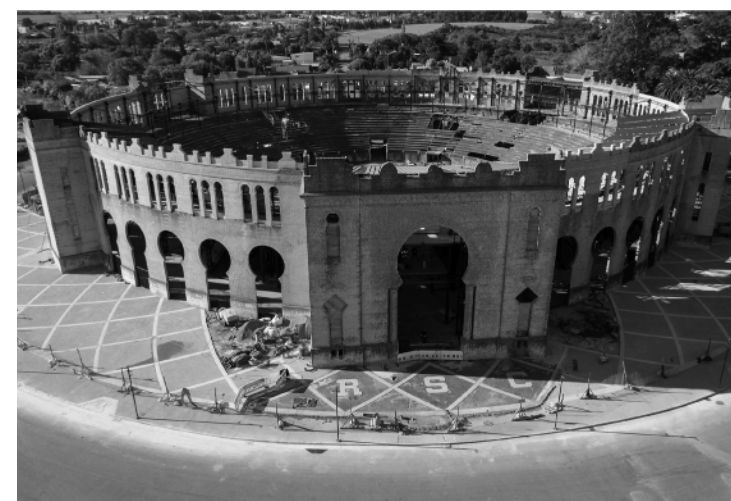
FIGURA 3. REGISTRO DEL HALLAZGO DE LAS LETRAS EN EL PAVIMENTO EXISTENTE (POSTERIOR A SU LIMPIEZA, SE OBSERVA SU ESTADO DE DETERIORO). INCORPORACIÓN DEL HALLAZGO EN EL DISEÑO Y CONSTRUCCIÓN DEL NUEVO PAVIMENTO. FOTOGRAFÍA: GUELL ESTUDIO.
