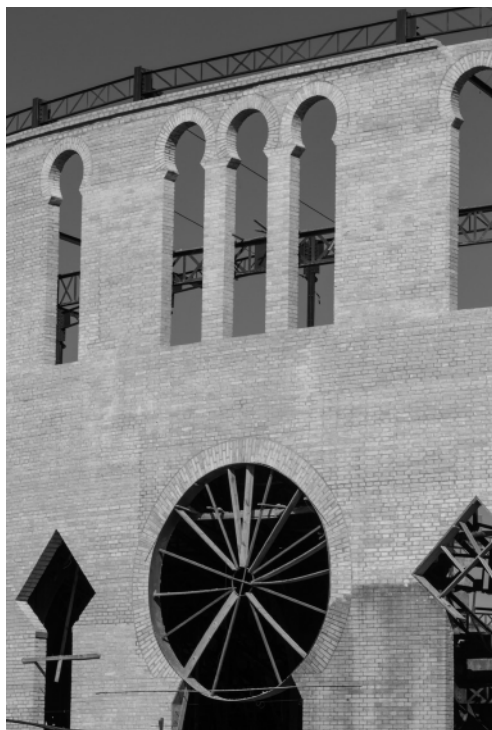
FIGURA 4. LA UTILIZACIÓN DE ENCOFRADOS DE CHAPA Y MADERA PERMITIÓ MOLDEAR LOS ARCOS DE LA FACHADA. FOTOGRAFÍA: GUELL ESTUDIO.
