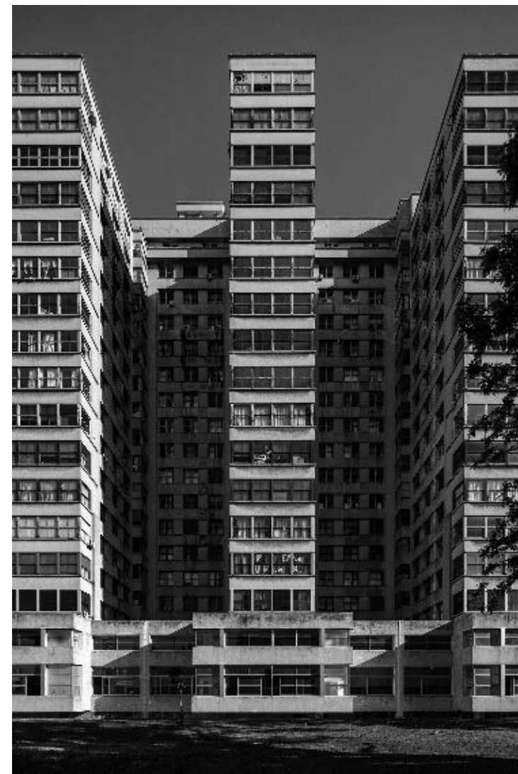
FIGURA 6. HOSPITAL DE CLÍNICAS, CARLOS SURRACO
