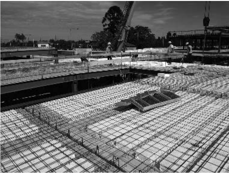
FIGURA 2. CUBIERTA ANTES DEL LLENADO DE LA CARPETA DE COMPRESIÓN.
