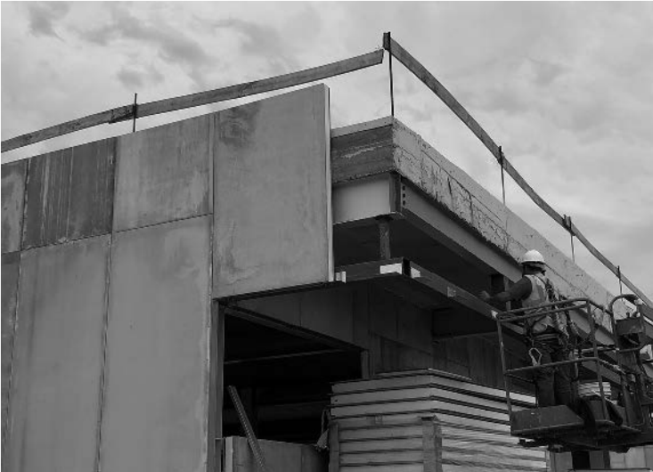
FIGURA 9. COLOCACIÓN DE PANELES DE FACHADA.
