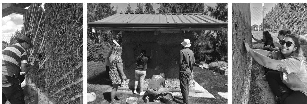
FIGURA 4: ESTRUCTURA SECUNDARIA DE CAÑAS EN DIAGONAL, RELLENO DE TIERRA ALIVIANADA Y APLICACIÓN DE REVOQUES DE ARCILLA PARA MUROS DE FAJINA
