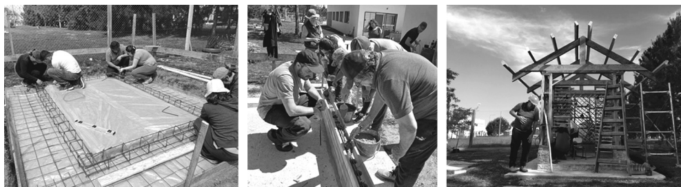
FIGURA 3: ETAPAS DE CIMENTACIÓN, SOBRECIMIENTO DE BTC Y ESTRUCTURA DE MADERA
