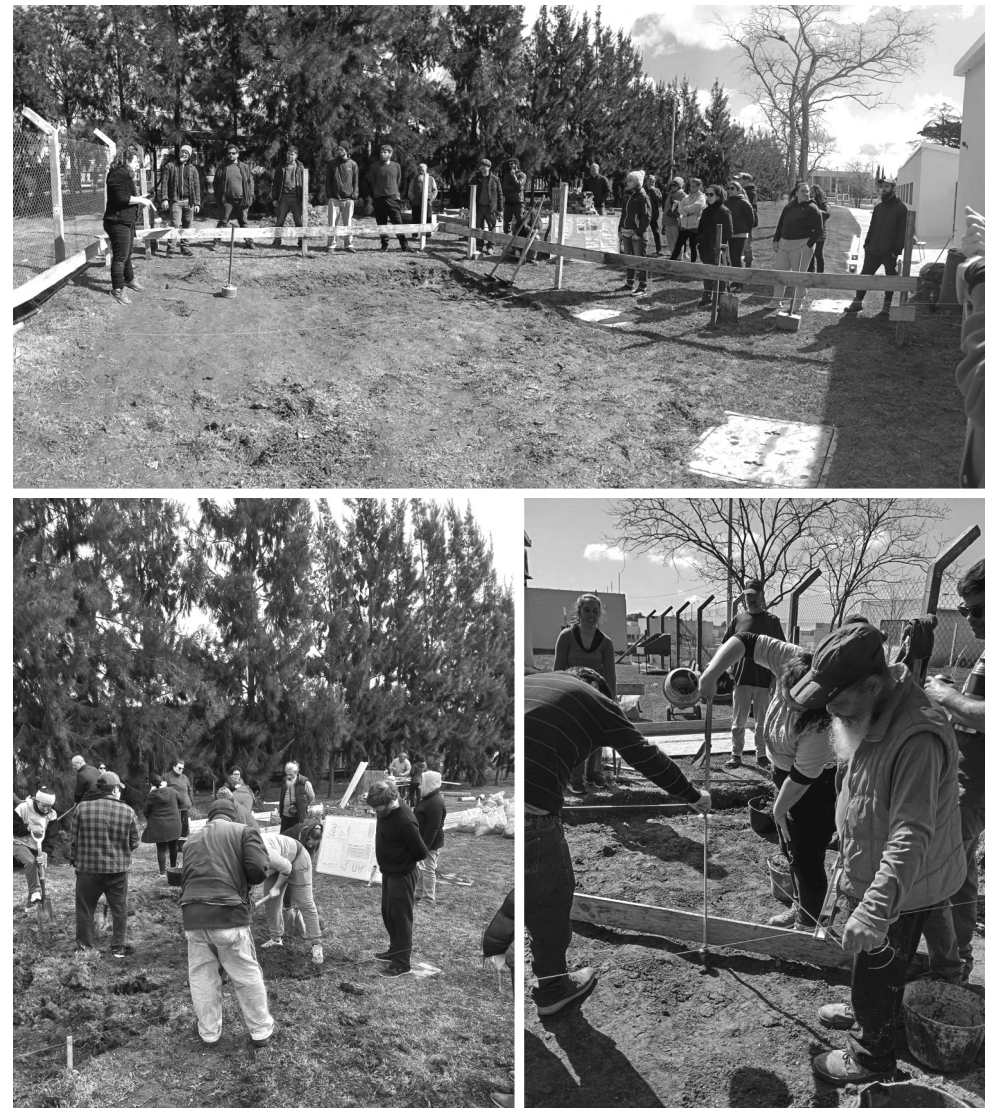
FIGURA 1: APLICACIÓN DE LA METODOLOGÍA DE OBRA-ESCUELA A PARTIR DE LA EXPLICITACIÓN Y REALIZACIÓN COLECTIVA DE TAREAS INICIALES DE LIMPIEZA DE TERRENO Y REPLANTEO
