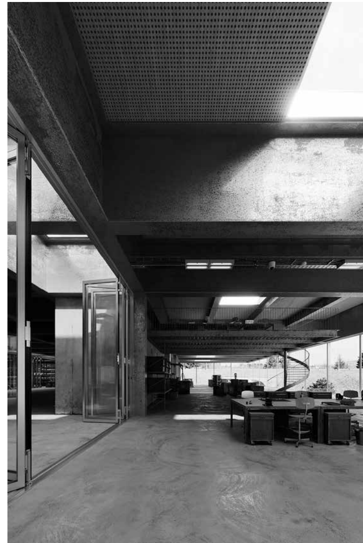
FIGURA 6. EJEMPLO DE CONSTRUCCIÓN HÍBRIDA. NUEVA SEDE PARA LA EMPRESA VITEOS S.A., LA CHAUX-DE-FONDS (SUIZA). PROYECTO EN CURSO, 2021-2026. GNWA. FUENTE: IMAGEN DE OLIVIER CAMPAGNE PARA ARTEFACTORYLAB
