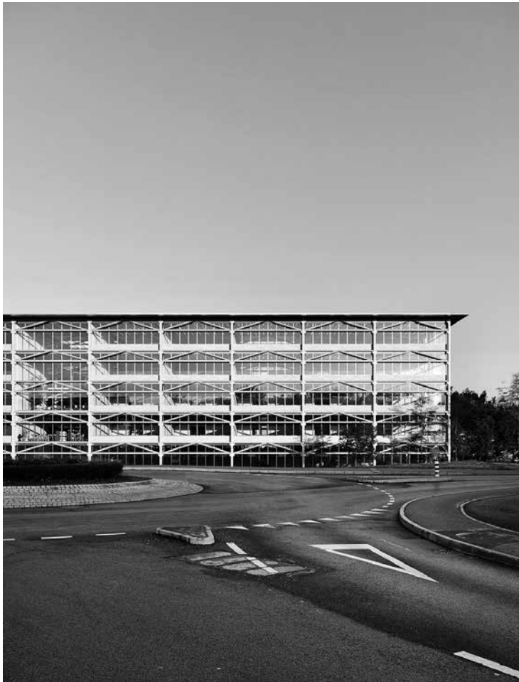
FIGURA 7. EJEMPLO DE ESTANDARIZACIÓN Y PREFABRICACIÓN. NUEVO CENTRO EDUCATIVO EN GIVISIEZ, FRIBURGO (SUIZA). CONCURSO, 2022. GNWA. FUENTE: IMAGEN DE OLIVIER CAMPAGNE PARA ARTEFACTORYLAB
