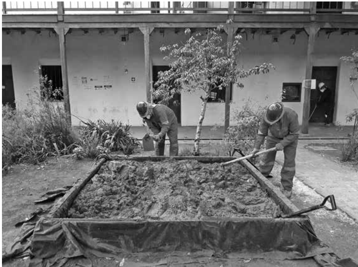
FIGURA 7. IMAGEN QUE MUESTRA LAS RECONSTRUCCIONES PARCIALES Y EL RESCATE DE ESTRUCTURAS DE MUROS, ENTREPISOS Y TECHUMBRES. FUENTE: FOTOGRAFÍA DEL AUTOR DEL ARTÍCULO
