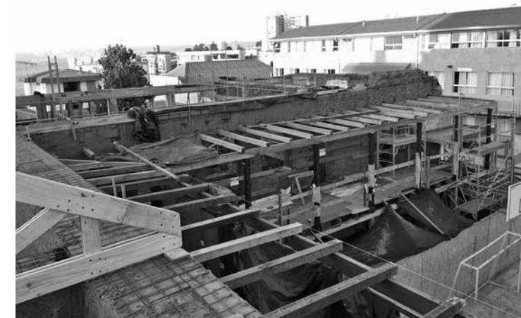
FIGURA 6. IMAGEN QUE MUESTRA LAS RECONSTRUCCIONES PARCIALES Y EL RESCATE DE ESTRUCTURAS DE MUROS, ENTREPISOS Y TECHUMBRES. FUENTE: FOTOGRAFÍA DEL AUTOR DEL ARTÍCULO
